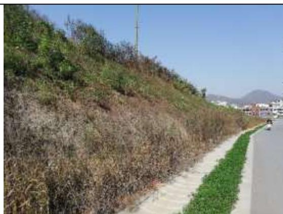
图 1-11 对路堑边坡侵蚀沟进行修整并完善植物措施
