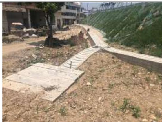
图 1-2 路堤边坡沉沙池法监测
