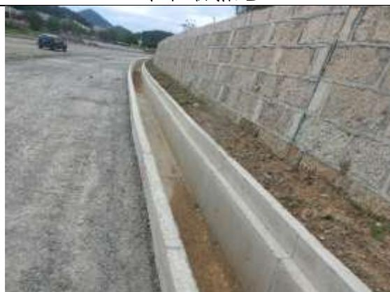
图 1-13 已安排对排水沟中淤积物进行清理
