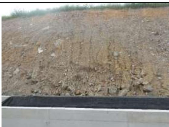
图 1-10 路堑边坡有侵蚀沟产生
