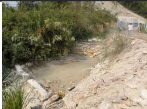
图 1-1 隧道口沉沙池法监测
