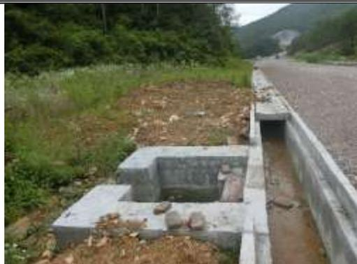
图 1-9 路基边坡沉沙池法监测
